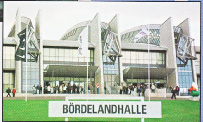
Bördelandhalle, Magdeburg Umbau zu einem multifunktionalen Event- und Business Center Bauvolumen: ca. 15 Mio. Euro
