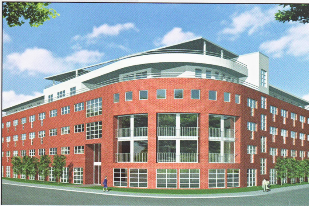
Seniorenwohnpark Langenfeld Vollstationäre Pflegeeinrichtung mit 94 Pflegeplätzen und Seniorenwohnungen Fertigstellung: Mitte 2006
